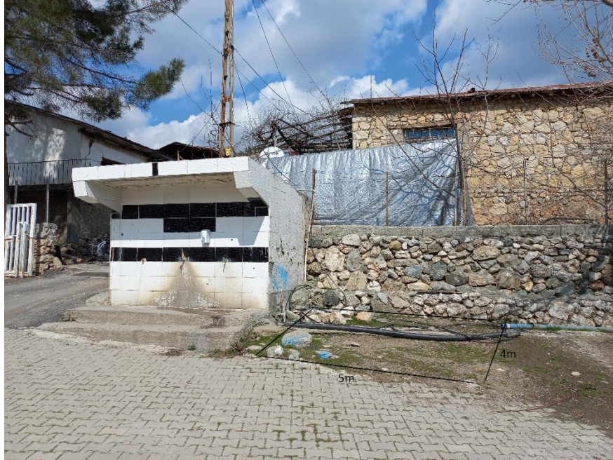
saha betonun döküleceği alan
