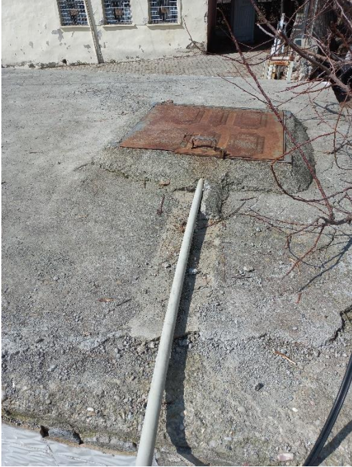
mevcut su deposu dolum tesisatı
