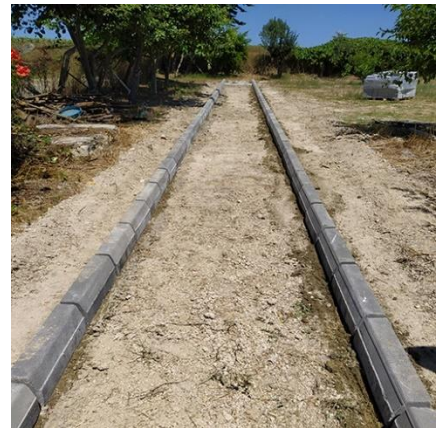
Fotoğraf: Örnek betonarme bordür ile yürüyüş yolu yapım işi
