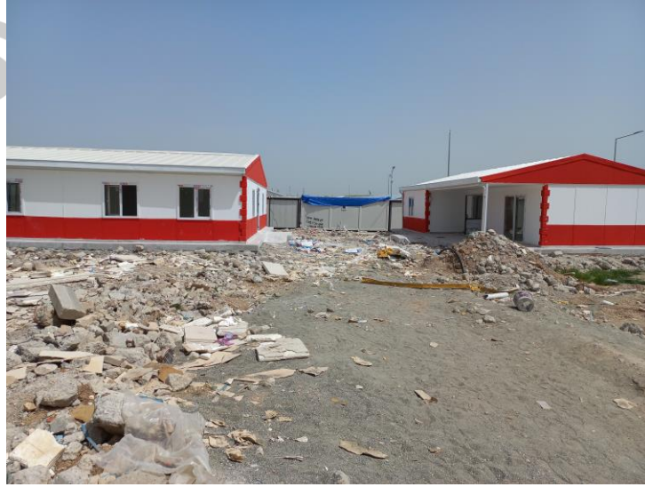
Fotoğraf: Saha tesviye çalışması sonrası 2 numara mıcır serilip tesviye yapılacak saha
