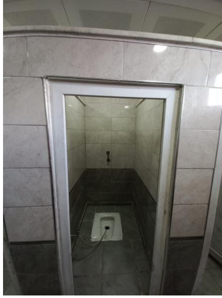
Fotoğraf 8: PVC Kapı işinin yapılacağı mahal
