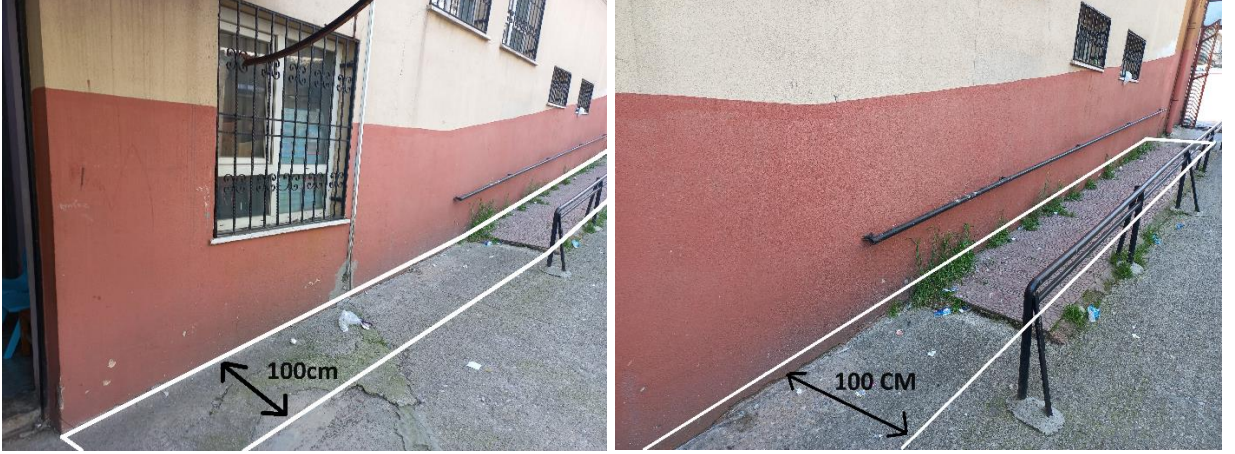
Fotoğraf 7: Bazalt döşeme ile tretuvar imalatı yapılacak mahal
