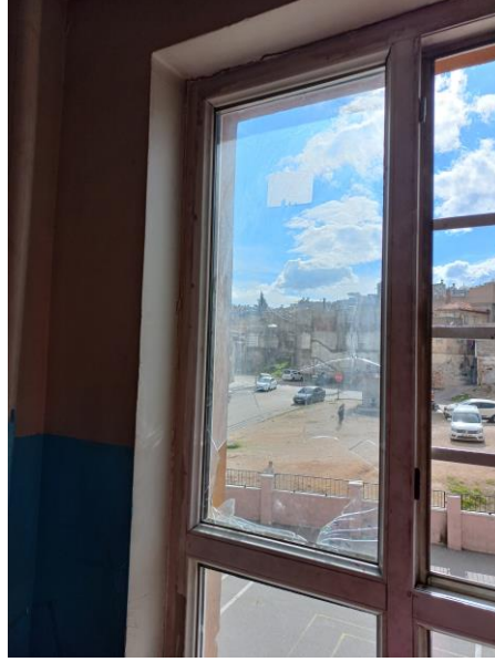
Fotoğraf 9: Bazı çift cam uygulama işinin yapılacağı mahaller
