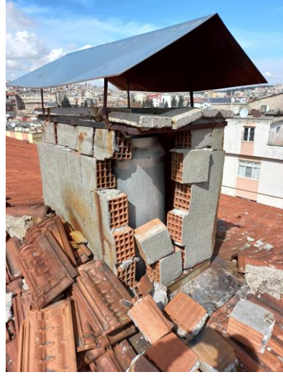
Fotoğra 5: Duvar örümü ve mozaik harpuşta uygulaması yapılacak mahal
