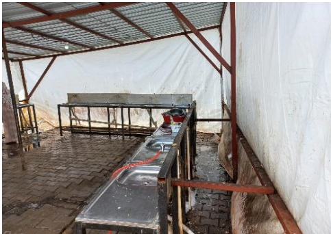
Fotoğraf: Evye montajı yapılacak yer
