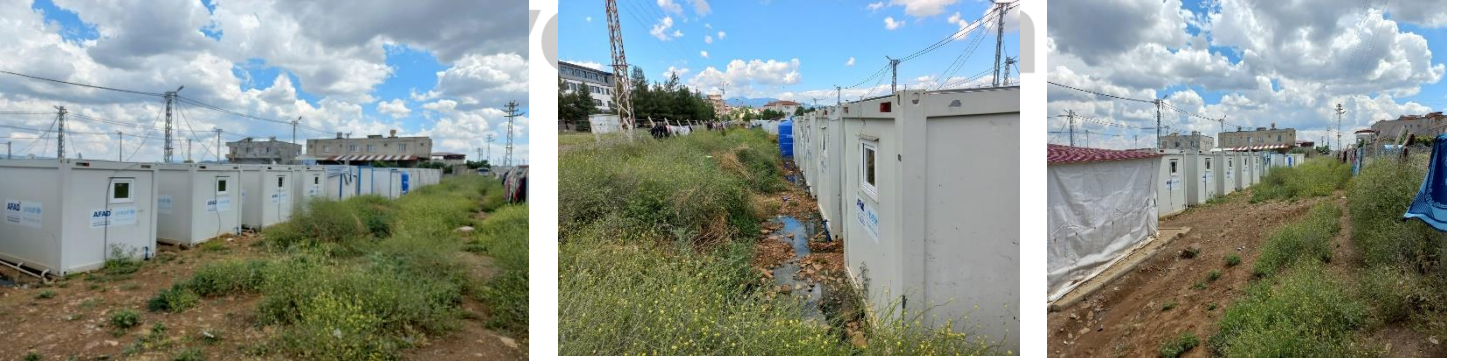
Fotoğraf: Uygulama Sahası fotoğrafları(Kaldırılacak Konteynırlar)
