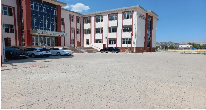
Resim: Panel Çit Uygulama Sahası
