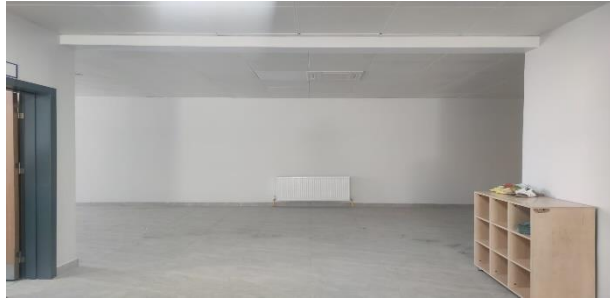
Fotoğraf: Alçıpan bölme duvar yapılacak yer
