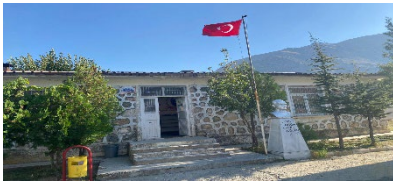
Fotoğraf:Yağmur oluğu uygulama sahası
