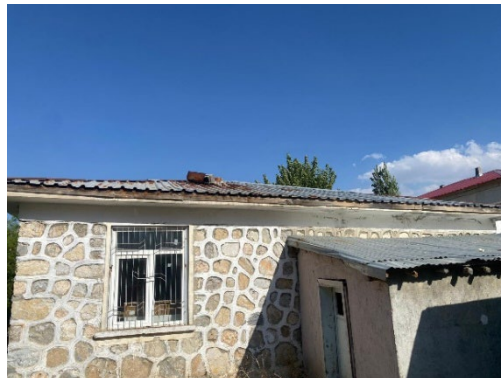
Fotoğraf: Demir kapı montajı yapılacak yer
