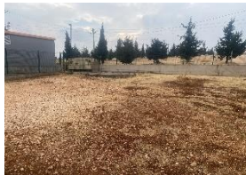
Örnek fotoğraf: Subasman betonu dökülecek saha
