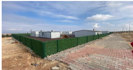
Fotoğraf: Beton kaideli hatıl yapılacak alan (panel çit demontajından sonra)
