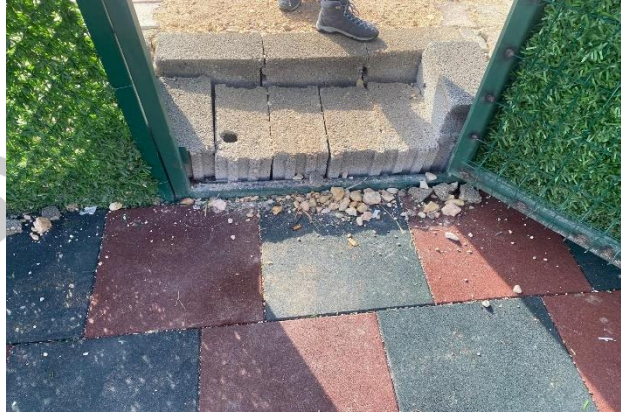
Fotoğraf: Engelli rampası yapılacak mahal
