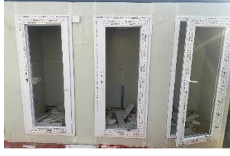
Fotoğraf: Kapı kanadı yapılacak mahal
