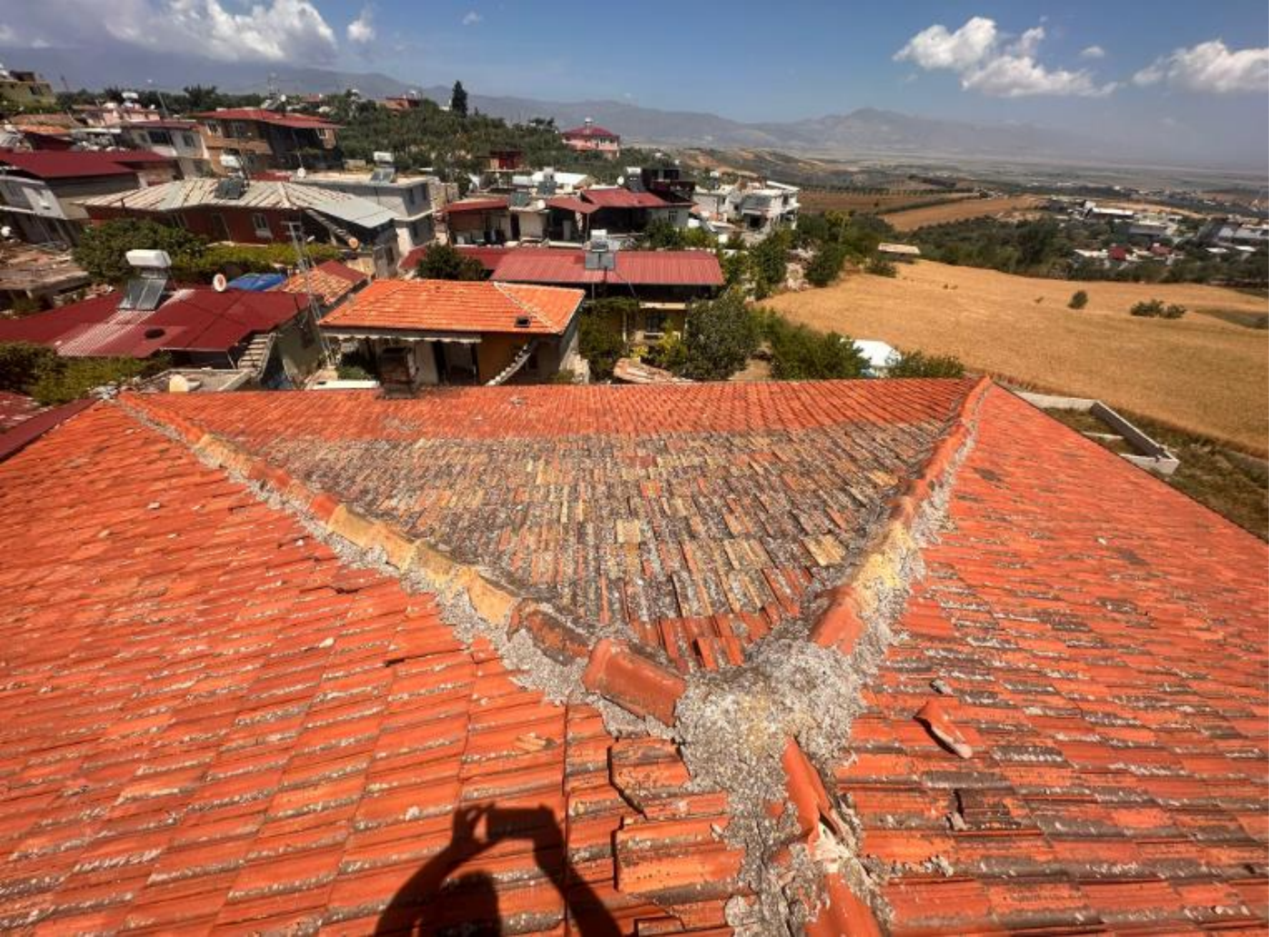
Çatı Yapılacak Alanlardan Bazı Fotoğraflar
